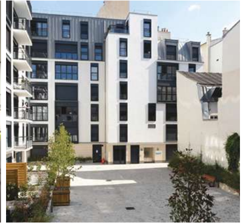
Paris 11e (75) Résidence Cour Saint-Louis Construction de 20 logements locatifs sociaux Architecte : Studio d'architecture ORY
